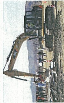
バックホウによるがれき除去
