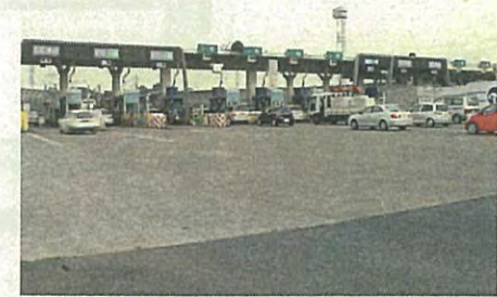
新座本線料金所(関越自動車道)
